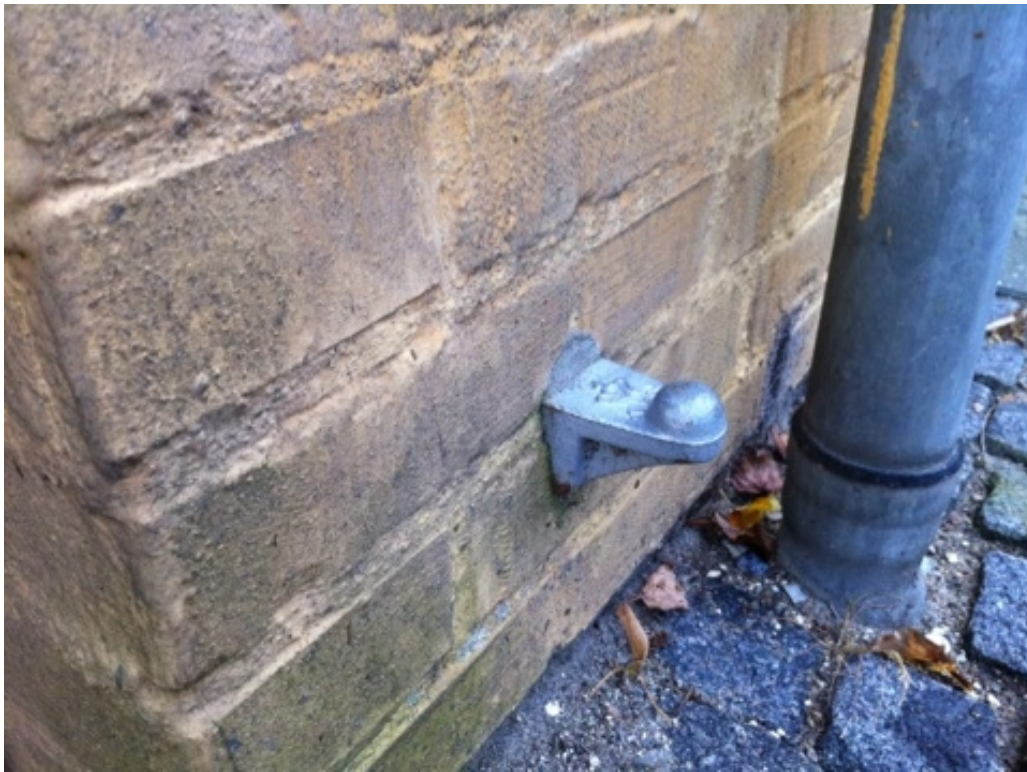
Figur 6: Nivellementsbolt - den typiske etableringsform for fikspunkter i Thyborøn.
