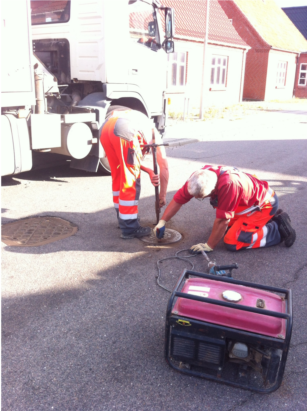
Figur 10: Der gøres forøg på at åbne et fastsiddende dæksel med mejselhammer og dækseljern.
