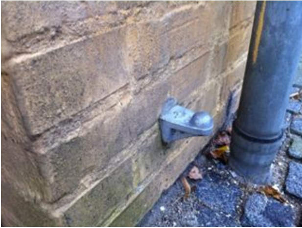
Figur 1: Nivellementsbolt – den mest udbredte etableringsform for fikspunkter.
